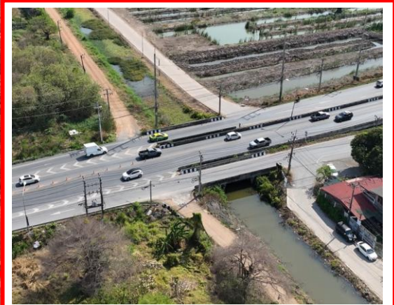
สะพานข้ามคลองส่งน้ำ 6 ซ้าย (กม.13+796)
